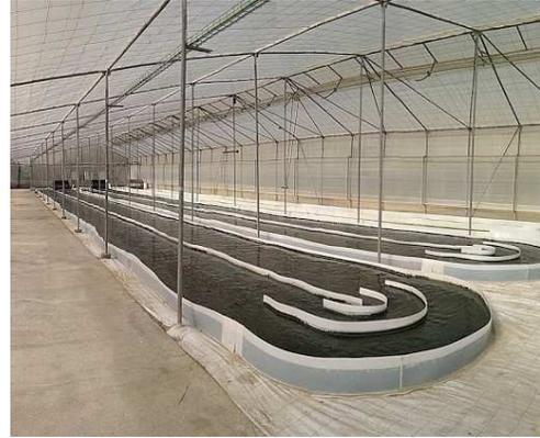
**Foto 1. Vista de una piscina “raceway” de cultivo industrial de microalga con inyección de CO<sub>2</sub> comercial en las instalaciones del Proyecto SABANA de la Unión Europea, Almería, España. Izquierda: en ambiente exterior. Derecha: dentro de un Invernadero en construcción.**
